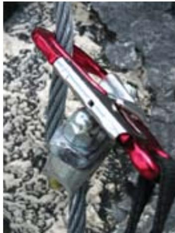
Abb.1 Die Biegebeanspruchung von Karabinern am Klettersteiganker ist je nach Drahtseilverankerung unterschiedlich hoch
