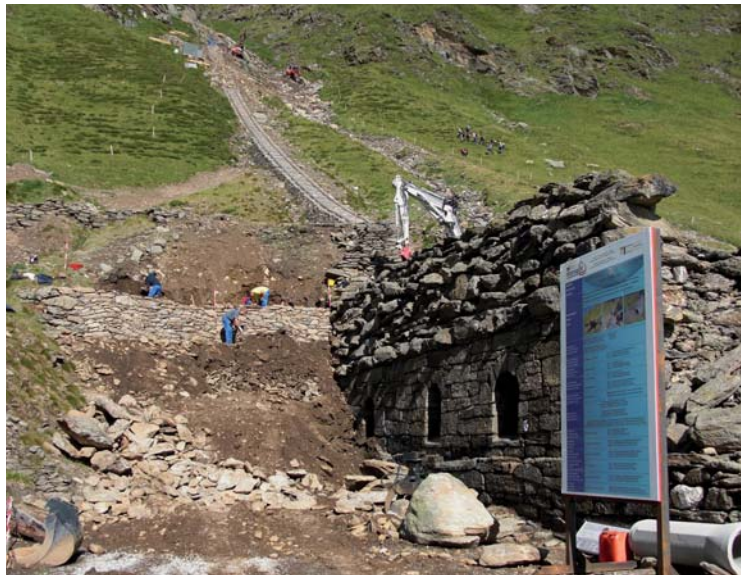
Sanierungsarbeiten am unteren Abschnitt des Lazzacher Bremsberges im Sommer 2010
