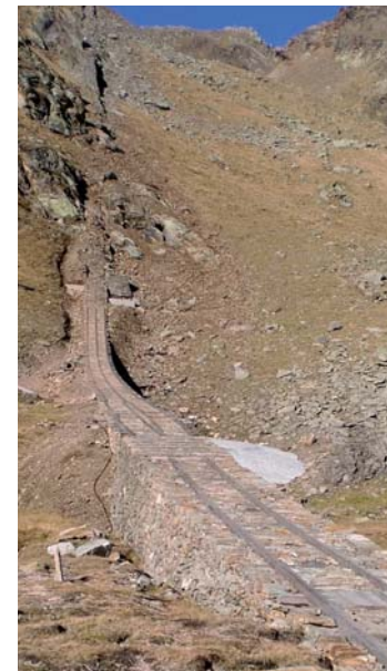
Sanierungsarbeiten am unteren Abschnitt des Lazzacher Bremsberges im Sommer 2010
