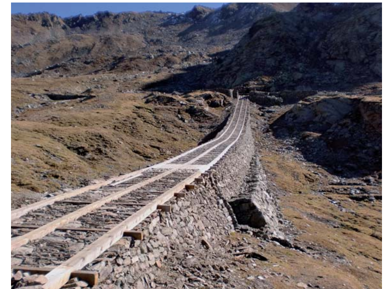
Oberer Teil des 14-Nothelfer-Wassertonnenaufzuges am Schneeberg mit Kaindljoch im Hintergrund Foto: Matthias Siller
