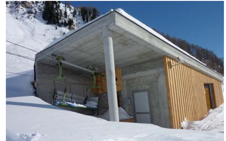
Die neue Talstation der Sesvennahütte
