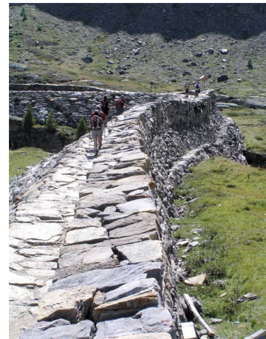
Die nach dem Gletschersee-Ausbruch 1891 errichteten Schutzbauten sind zum Großteil heute noch vorhanden
