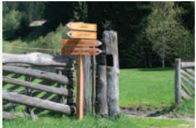
Alle Wegweiser eines Pfostens müssen vom unmittelbar verlaufenden Weg aus sichtbar für den Wanderer sein. Die Anordnung der Wegweiser am Pfosten erlaubt deshalb nur die Verwendung von jeweils zwei aneinanderliegenden Pfostenseiten und deren gemeinsame Kante.
