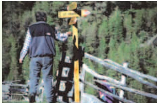
Der Wegweiser sollte an idealer Stelle montiert werden, sodass äußere Einwirkungen wie Straßenverkehr, Wild- und Weidetiere sowie Erosion die Dauerhaftigkeit nicht beeinträchtigen.
